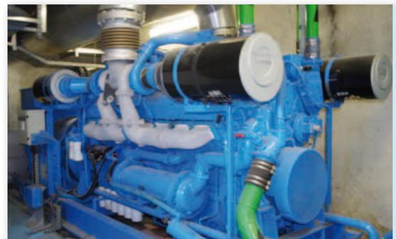
Groupe électrogène pour la protection des salles machines
